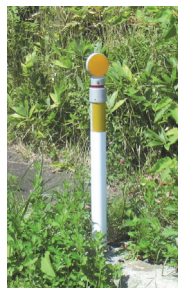
40：道路附属物「視線誘導標」
