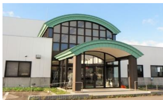
函館市リサイクルセンター
