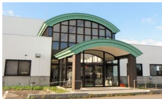
函館市リサイクルセンター
