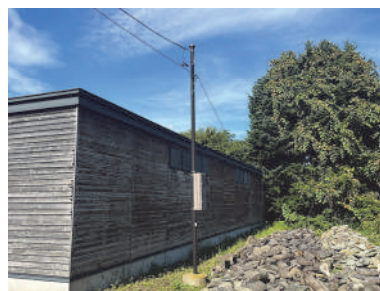
41：電柱 「管理棟北側」
