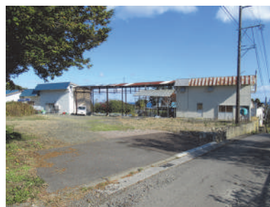
24：漁業関連施設(コンブ加工施設)
