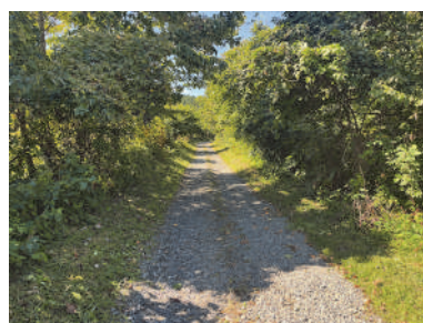
21：管理用通路(旧市道)
