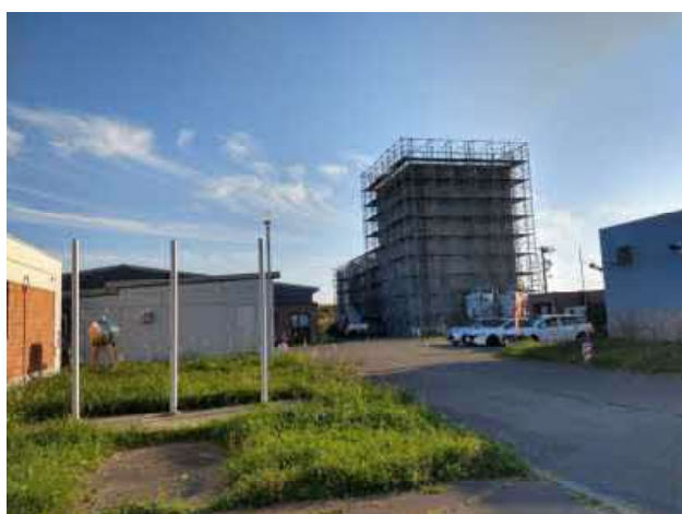
羽幌センター改修工事（計画修繕）
