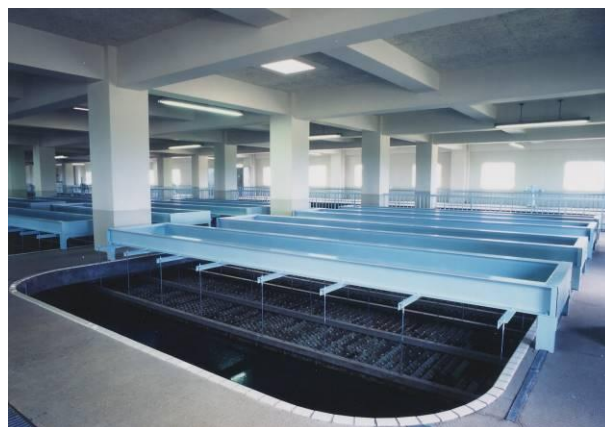
旭岡浄水場 (薬品沈でん池)
