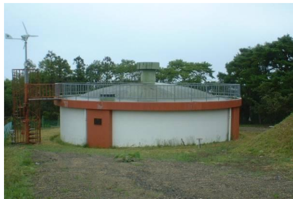
大船浄水場（配水池）
