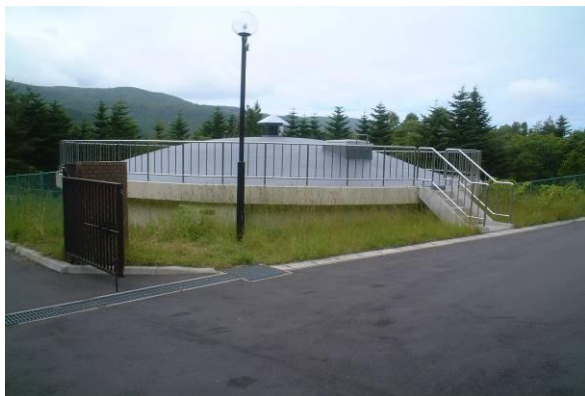
楳法華浄水場（配水池）
