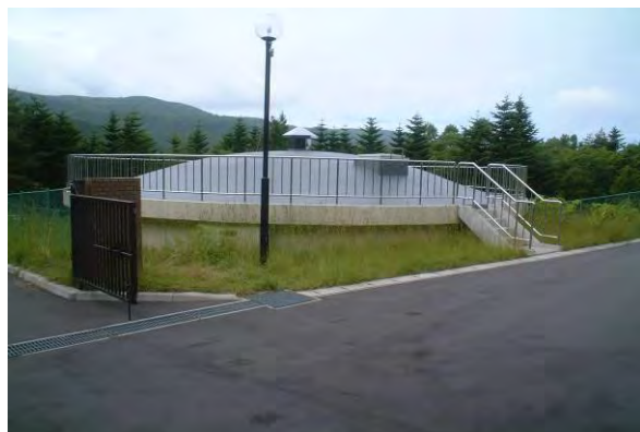
楳法華浄水場（配水池）
