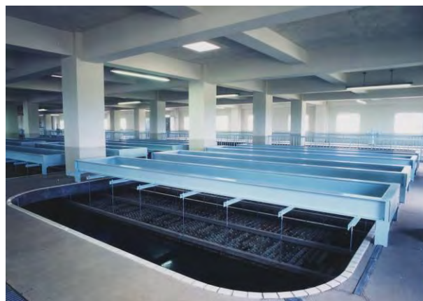
旭岡浄水場 (薬品沈でん池)
