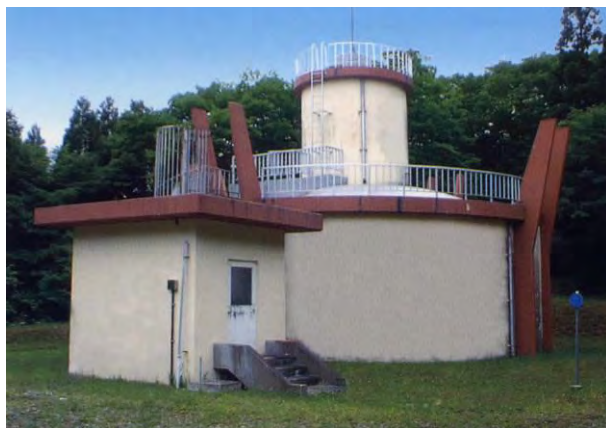
日ノ浜浄水場（配水池）
