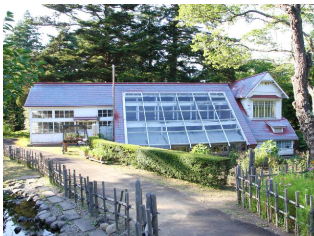
明治時代後半に造られたとされる旧式温室
