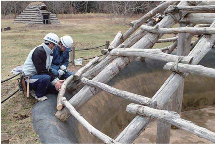
脱落した木材の補修
