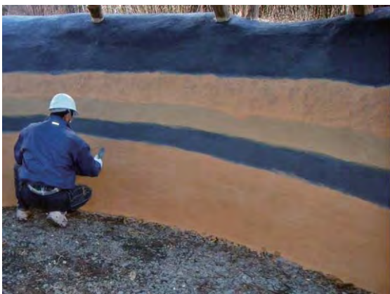
写真15 塗り壁材塗装状況
