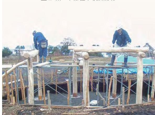
写真 18 ト層建て込み状況
