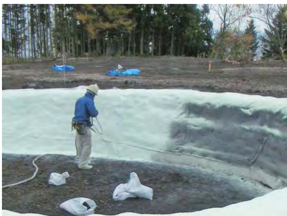
写真5 壁面ウレタン吹付状況
