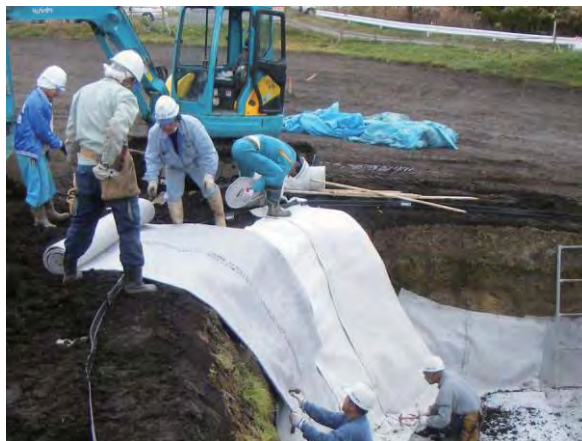
写真4 壁面不織布敷設状況
