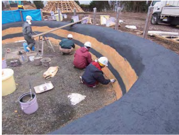
写真6 塗り壁材塗装状況
