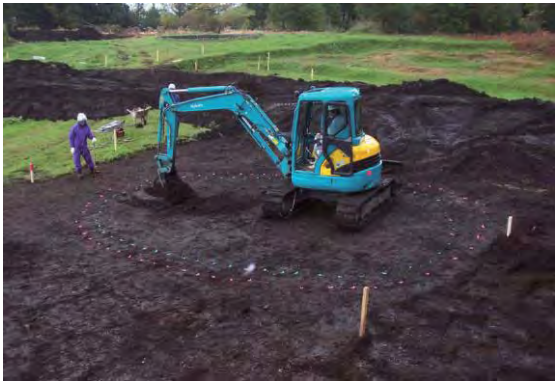
写真9 位置出し・掘削状況
