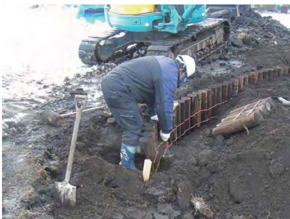
写真 29 平面表示 1 (杭設置状況)
