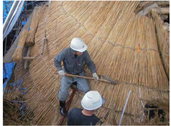
写真 26 茅葺き施工状況 2
