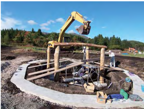
写真11 柱建て込み状況
