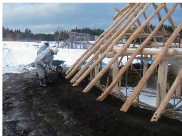
写真 22 土盛り施工状況
