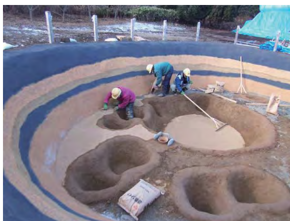
写真8 床面土舗装敷設状況
