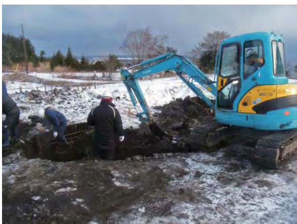
写真 31 平面表示 2 (掘削状況)
