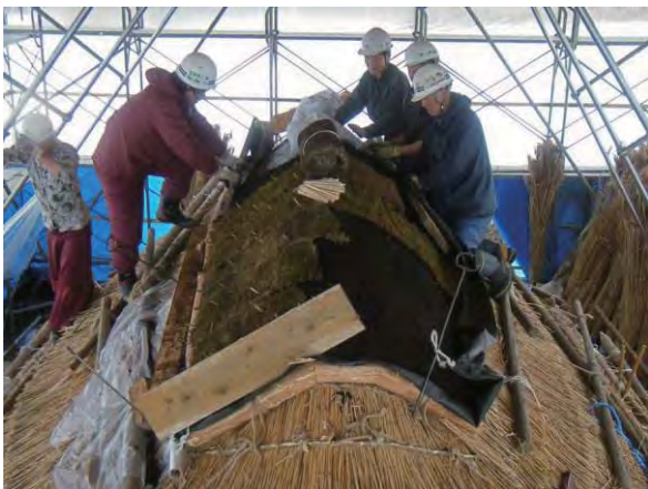
写真 27 芝棟施工状況
