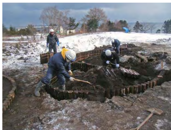
写真 32 平面表示 2 (杭設置状況)
