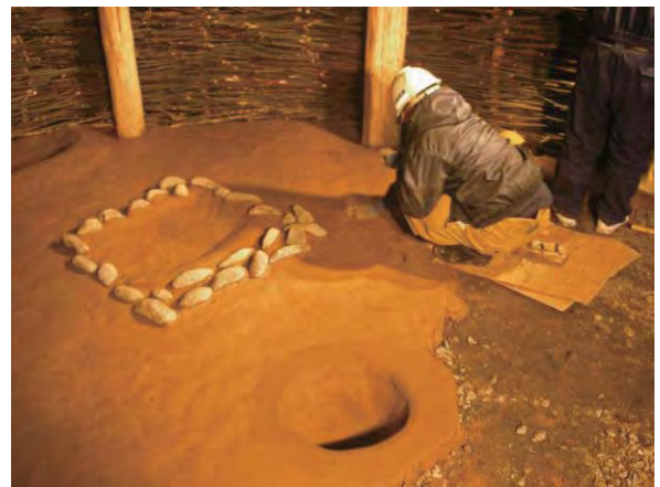
写真 28 土舗装施工状況
