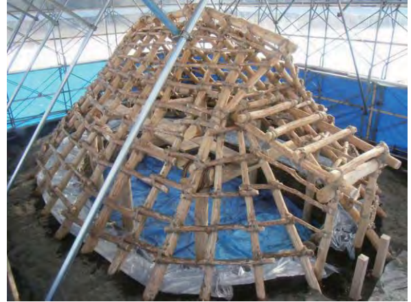
写真 24 骨組完成状況
