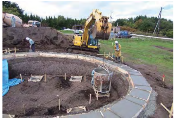
写真10 垂木基礎・柱基礎打設状況
