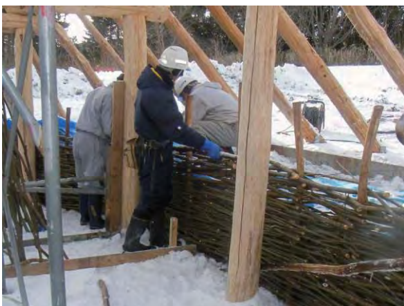
写真 21 土留めソダ組施工状況
