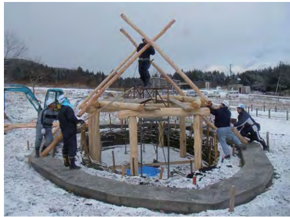
写真 20 垂木建て込み状況
