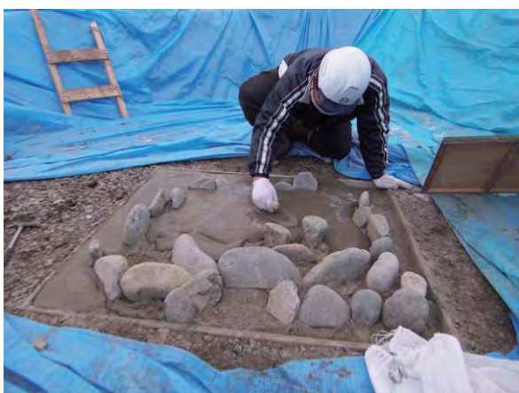
写真7 炉跡表示施工状況
