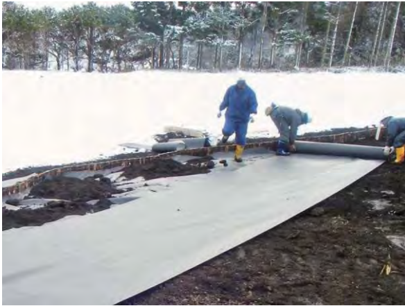
写真 35 盛土遺構施工状況
