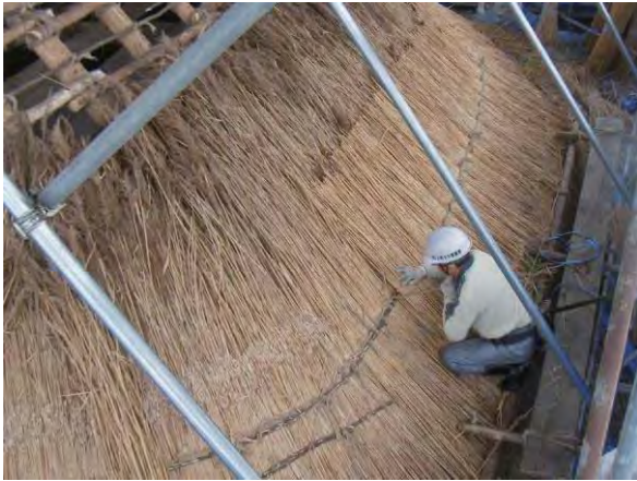
写真 25 茅葺き施工状況 1
