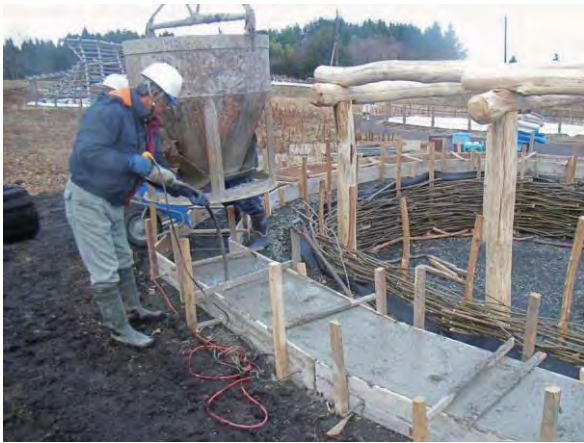
写真 19 垂木基礎打設状況
