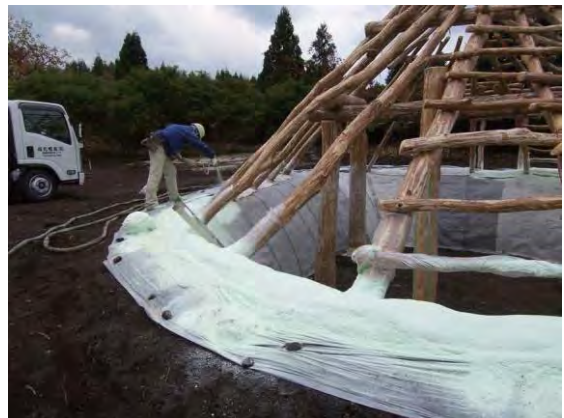
写真14 壁面ウレタン吹き付け状況
