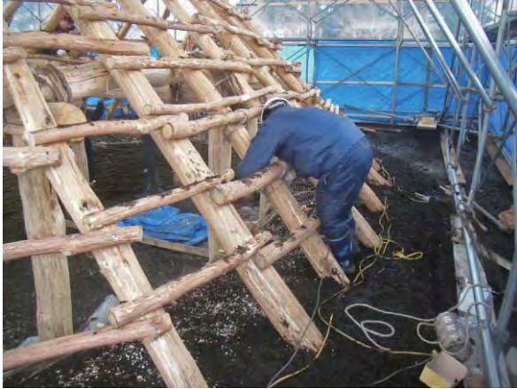
写真 23 棧設置状況
