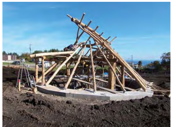
写真12 垂木建て込み状況
