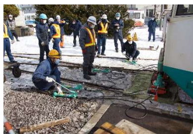
脱線復旧訓練
