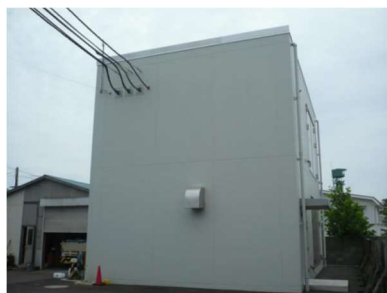
駒場町変電所
