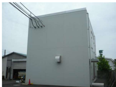
駒場町変電所
