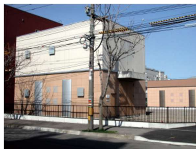
東雲町変電所
