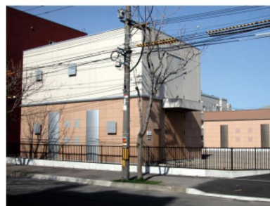
東雲町変電所
