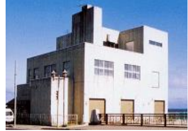
宇賀浦中継ポンプ場 (汚水)
