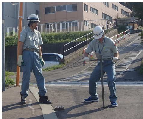
断水作業仕切弁操作訓練
