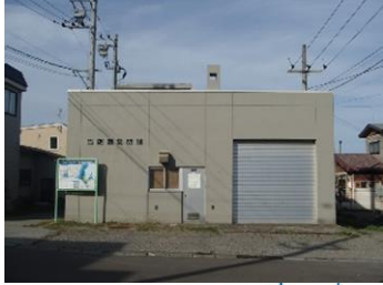
住吉ポンプ場 (汚水・雨水)
