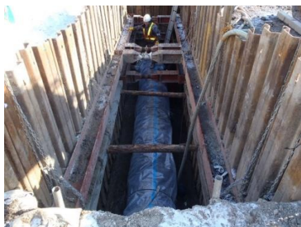
配水管布設工事
