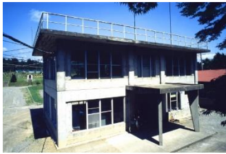
赤川低区浄水場
