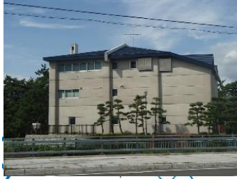
湯川ポンプ場 (汚水)
