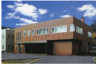
赤川高区浄水場
