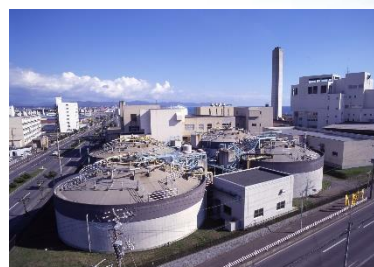
南部下水終末処理場 汚泥処理施設
