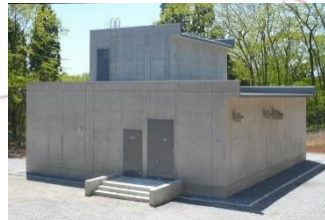
日ノ浜浄水場
