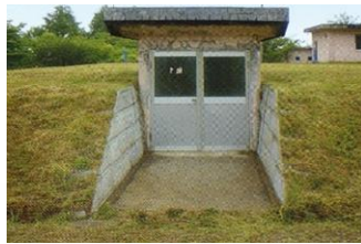
尾札部浄水場
