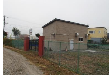
港ポンプ場 (雨水)
