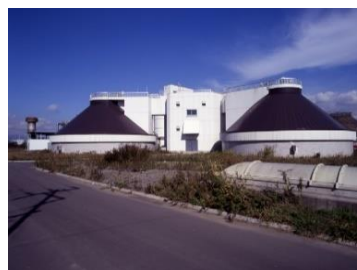
函館湾浄化センター汚泥処理施設
