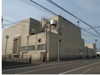
大手ポンプ場 (雨水)
