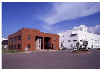
函館湾浄化センター管理棟
