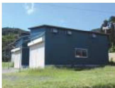
31：漁業関連施設（コンブ加工施設）
