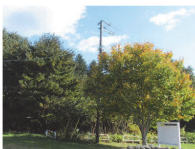
41：電柱 「管理棟東側」
