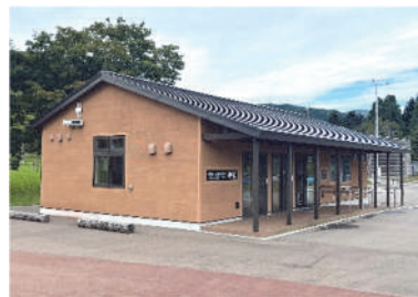
写真10-2 史跡垣ノ島遺跡 (管理棟)
