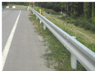
33：ガードレール
