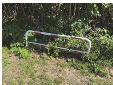
37：ガードレール(赤白ポール)
