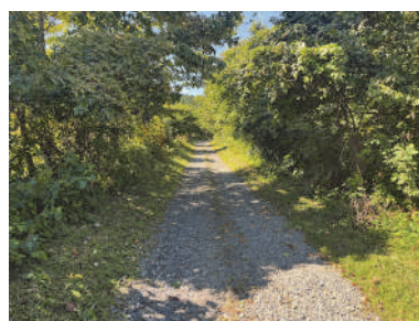
21：管理用通路(旧市道)
