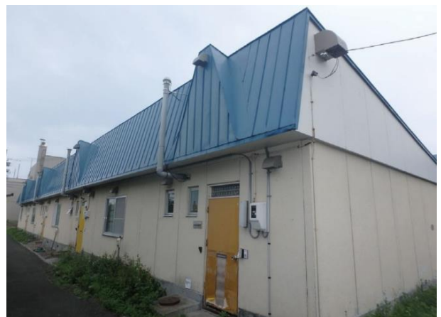
No. 2 新浜町団地
