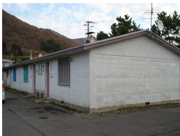
No.2 釜谷町団地
