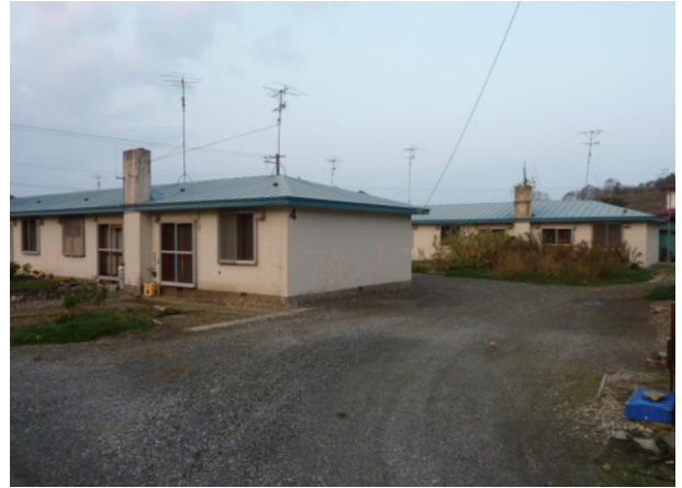
No.1 八木川団地
