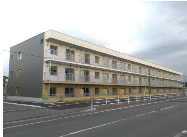
No.6 大川団地
