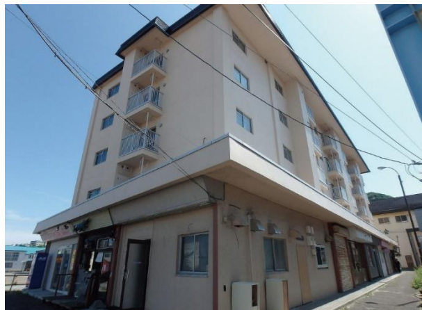
No.2 大町改良団地
