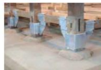
C 軸部の補強 (床下)
