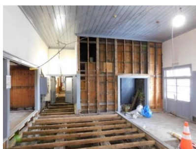
床板の解体（本館1階） 床板・壁板の解体（附属棟） 傷んだ柱材（本館2階）
