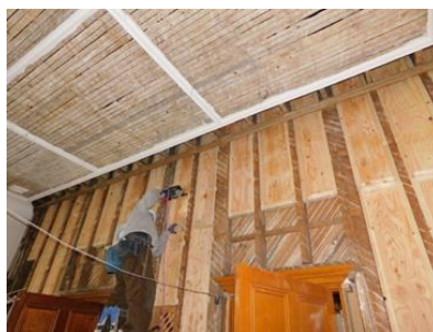
小屋裏の補強（本館） 壁の補強（本館2階） 床下基礎の補強（附属棟）
