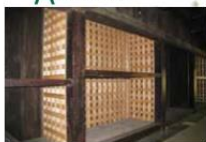
A 壁面の補強
