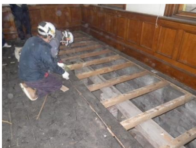
床板の解体（本館1階） 床板・壁板の解体（附属棟） 傷んだ柱材（本館2階）
