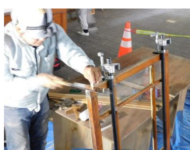
傷んだ柱材の交換（本館2階） 建具の補修（本館2階） 外壁の塗り直し（本館）
