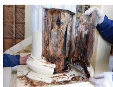
床板の解体（本館1階） 床板・壁板の解体（附属棟） 傷んだ柱材（本館2階）
