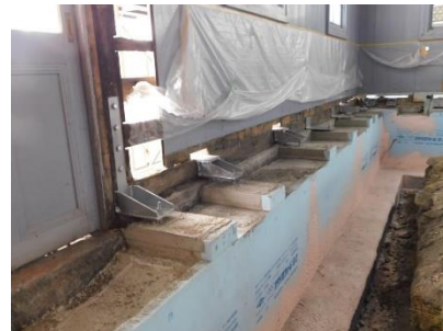
小屋裏の補強（本館） 壁の補強（本館2階） 床下基礎の補強（附属棟）
