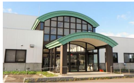
函館市リサイクルセンター
