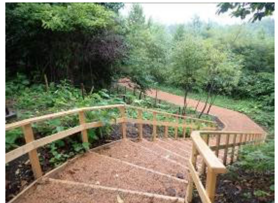
史跡外駐車場からの階段
