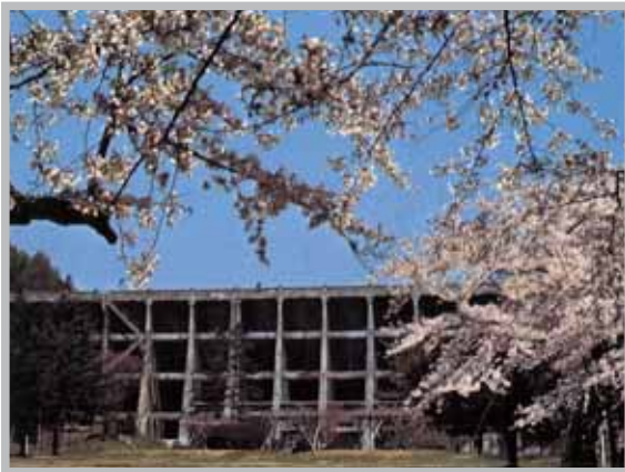
改修前の笹流ダム
