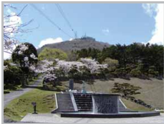
現在の元町配水場
