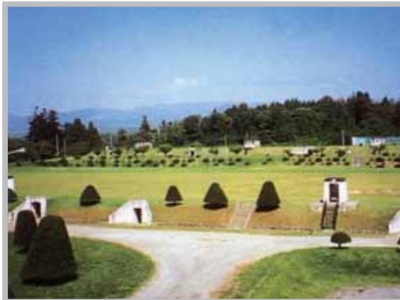
現在の赤川低区浄水場
