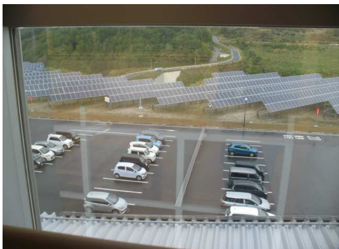
太陽光パネル
