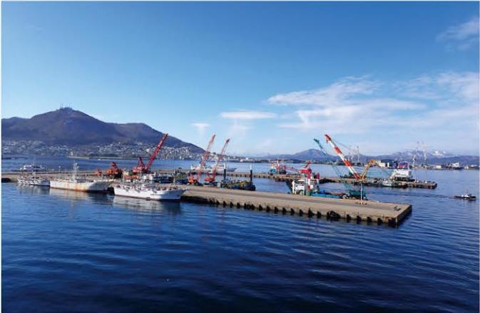
▲海岸町地区 海岸町船だまり
