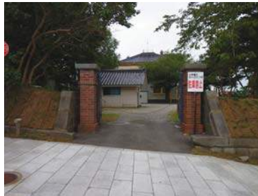
【東門】昭和37年 煉瓦張門柱2基、間口約3.2m、 木製門扉付
