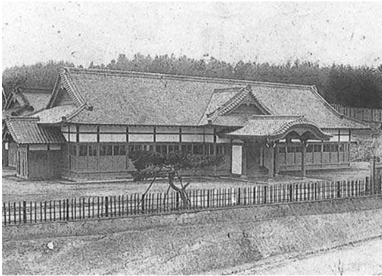
小樽区公会堂（小樽市／明治44年） ※『明治大正期の北海道一写真と目録〈写真編〉』から
