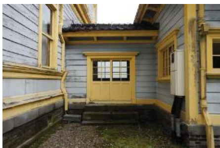
写真 5-12. 附属棟渡廊下 (右図⑤)
