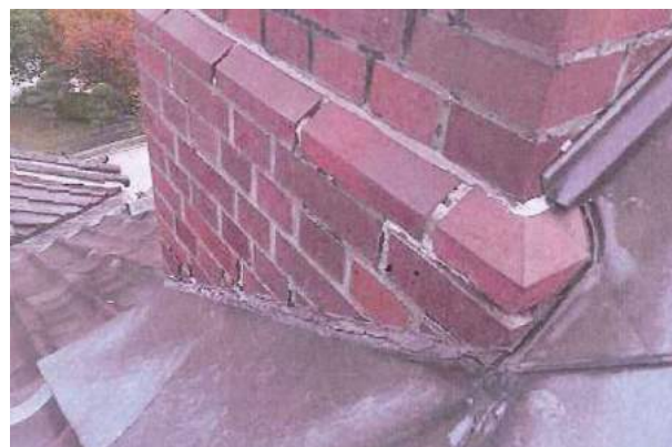
煙突取付き部のコーキング補修 (本館屋根)
