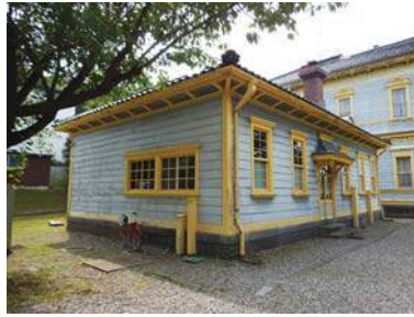
【附属棟】明治43年 木造、建築面積133.9㎡、一階建、 渡廊下附属、棧瓦及び鉄板葺
