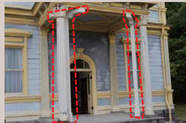
補強柱(本館 西側車寄せ)
