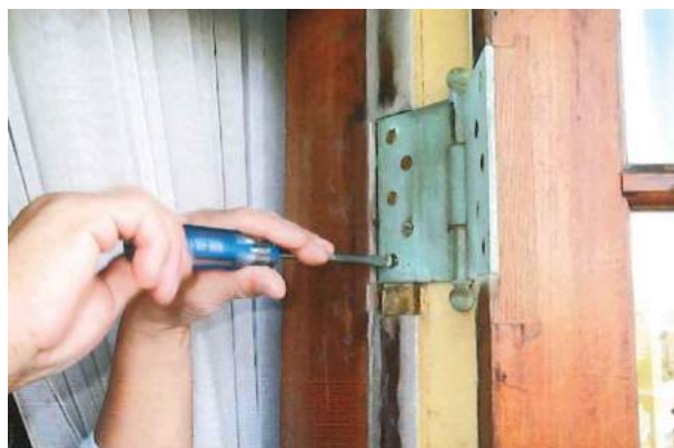
建具金具の締め付け調整 (本館甲板)
