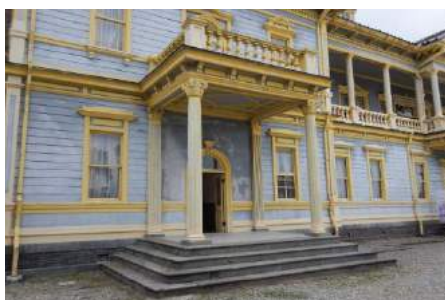
写真 5-11. 本館東側玄関 (右図②)
