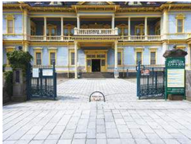
【正門】明治43年頃 石造門柱2基、間口約8.2m、 鑄鉄製門扉付 ※伝統的建造物は門柱のみ 門扉は昭和37年頃
