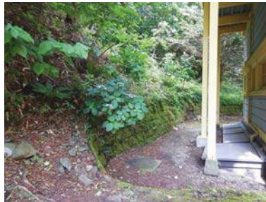
【石垣(背面)】※年代確認 石造、総延長約86m、 昭和修理時に一部整備
