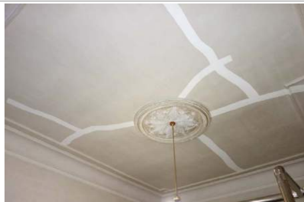
漆喰の補修 (本館事務室)
