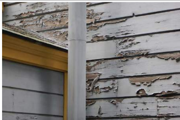
下見板の補修 (本館東側)
