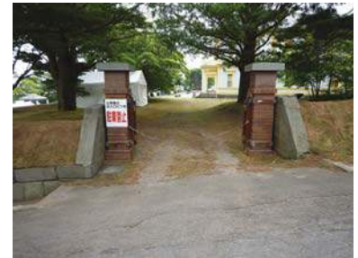
【西門】昭和37年頃 煉瓦張門柱2基、間口約3.2m、 木製門扉付
