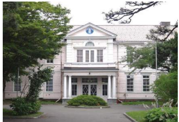
遺愛学院 本館（函館市／重文／明治41年）
