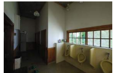
写真 5-18. 共用便所（現状）
