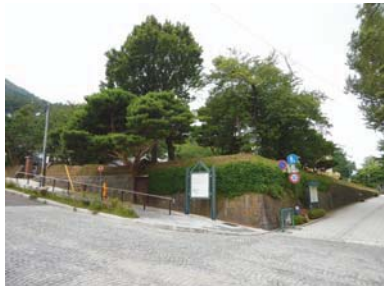
【石垣(正面)】明治43年頃 石造、総延長約115m、 上部に土塁を築く
