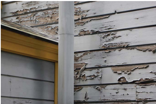
下見板の補修（本館東側）
