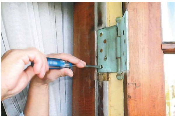
建具金具の締め付け調整（本館 甲板）
