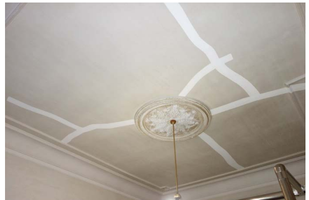
漆喰の補修（本館 事務室）
