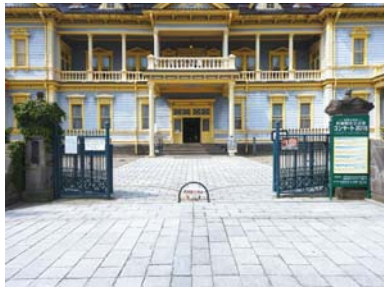
【正門】明治43年頃 石造門柱2基、間口約33m、 鑄鉄製門扉付 ※伝統的建造物は門柱のみ 門扉は昭和37年頃
