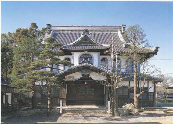
旧遠江国報徳社公会堂（静岡県／重文／明治36年） ※『大日本報徳社大講堂 保存修復工事報告書』から
