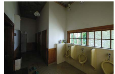
写真. 共用便所 (現状)
