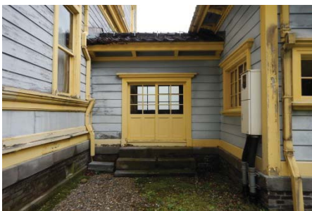
写真. 附属棟渡廊下(背面側)
