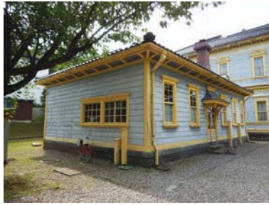
【附属棟】明治43年 木造、建築面積133.9㎡、一階建、 渡廊下附属、棧瓦及び鉄板葺
