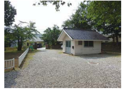
【ポンプ小屋】昭和57年 木造、平屋建、棧瓦葺
