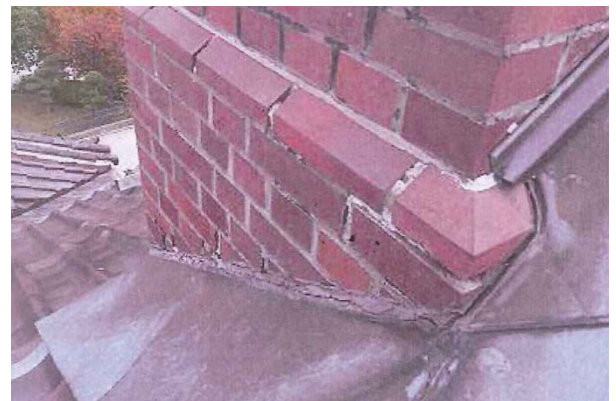
煙突取付き部のコーキング補修（本館屋根）
