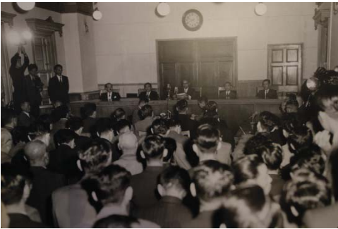
函館地方海難審判庁（大食堂/昭和26年頃）
