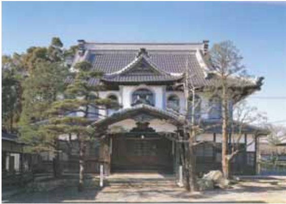
旧遠江国報徳社公会堂（静岡県／重文／明治36年） ※『大日本報徳社大講堂 保存修復工事報告書』より
