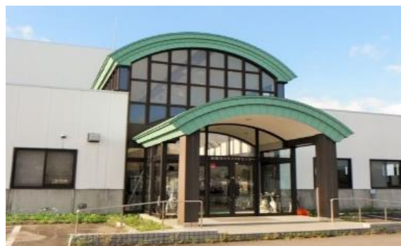
函館市リサイクルセンター
