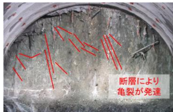
【特徴1】断層運動に伴う弱部の形成
