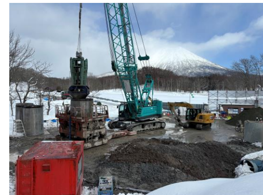
岩塊撤去状況
