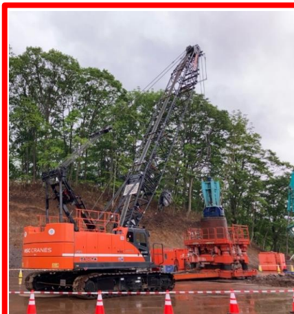
岩塊撤去状況
