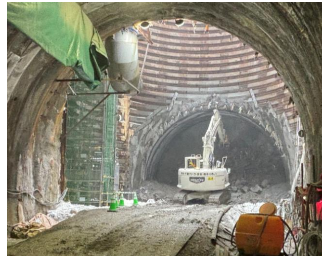
到達立坑からNATM掘削状況
