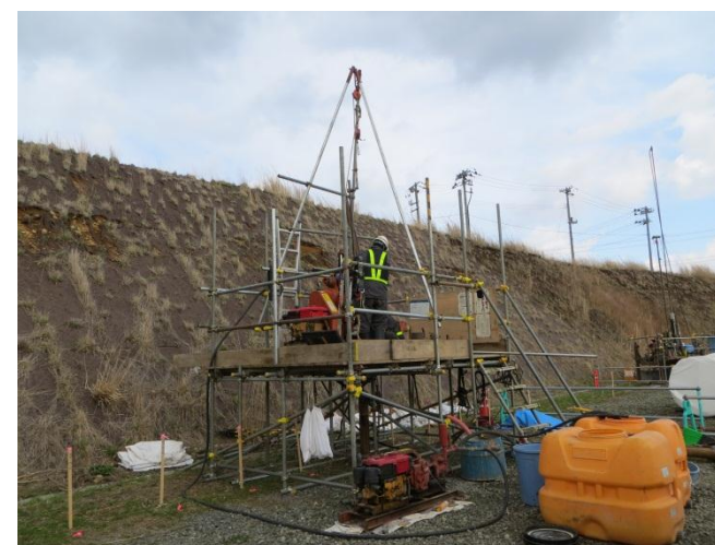
図4 ボーリング調査作業状況（事例）
