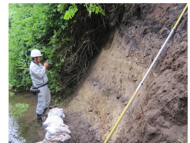
図5 露頭調査作業状況（事例）
