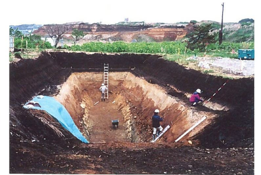
図5 トレンチ調査作業状況（事例）
