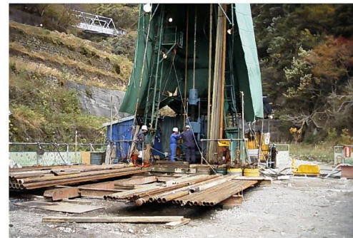
図4 大深度ボーリング作業状況（事例）
