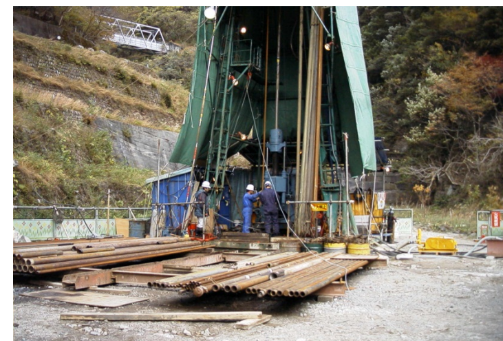
図4 大深度ボーリング作業状況（事例）
