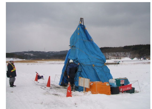
図 7 ボーリング調査状況
