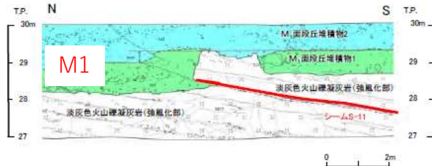
Ts-7トレンチ東側法面: 変状が認められる (比高約30cm[段丘堆積物中の層理面の段差]) (補足説明資料P.4-20参照)
