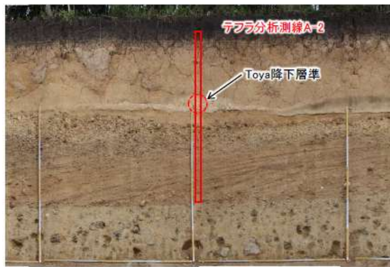
図2.2 法面④詳細画像
