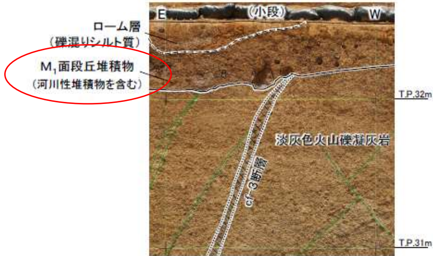
図3.19 Tf-5(a)トレンチ南側法面詳細写真(解釈線有り)
