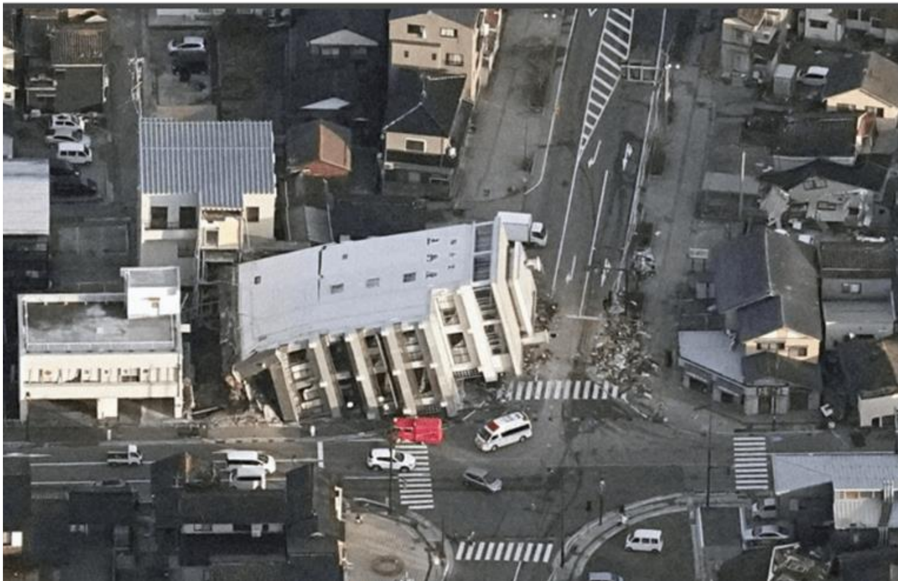
輪島市 震度6強 7階建てビルが根元から横倒し(甲F153、甲F154)
