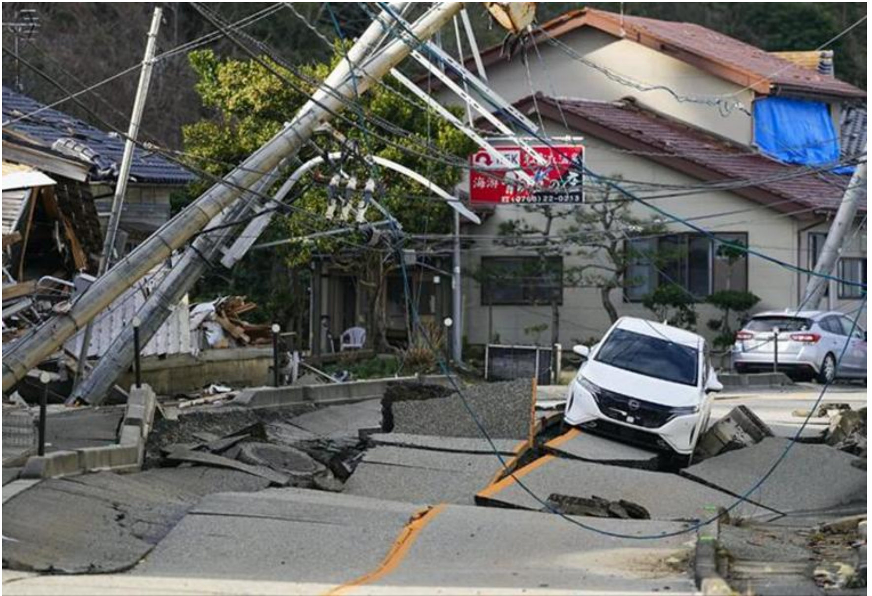
輪島市 国道247号線 (甲F152)
