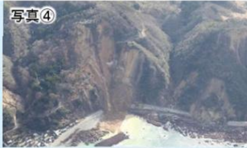
国道249号法面崩落
