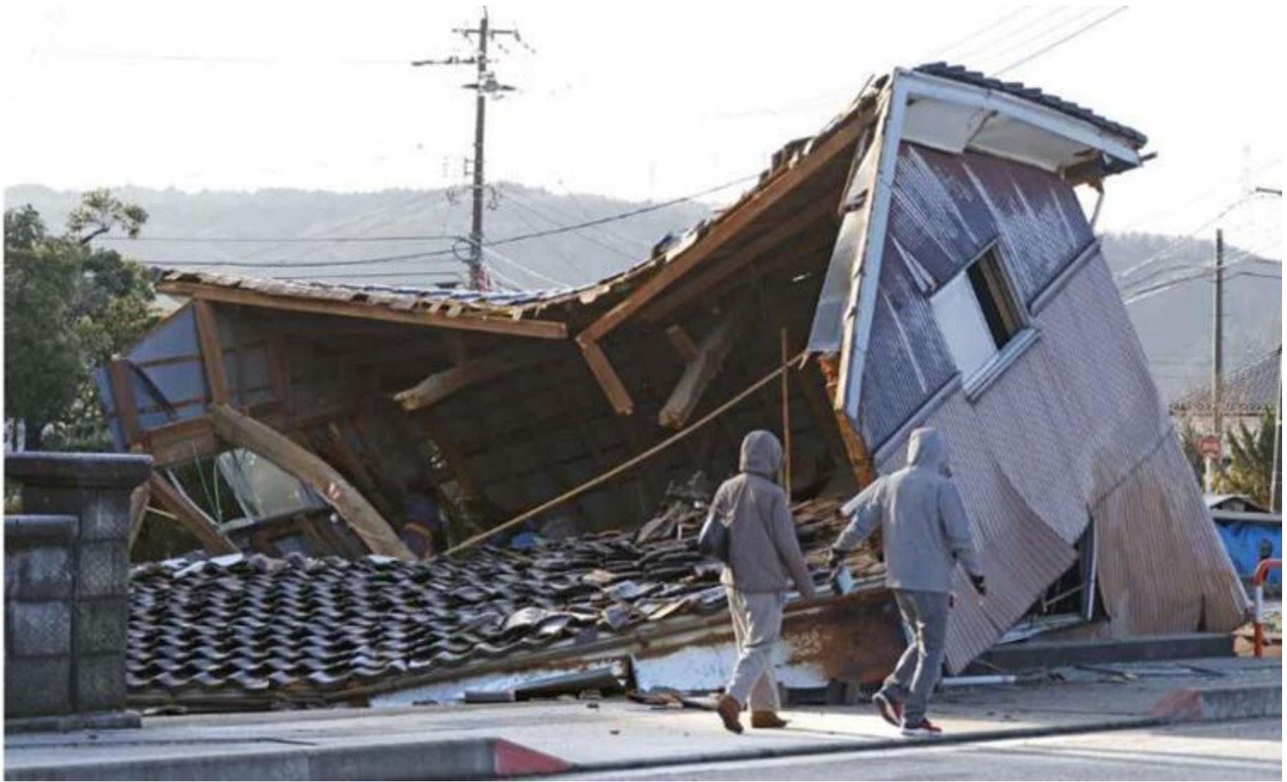
志賀町 震度7 被害棟数4535棟(1月29日時点) (甲F151、甲F163) 5
