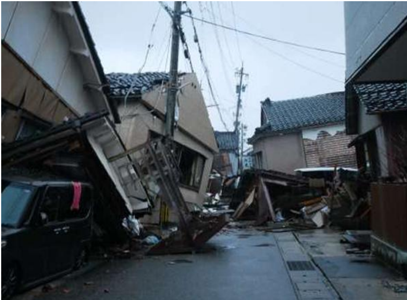
輪島市 震度6強 被害棟数1886棟(1月29日時点)(甲F166)
