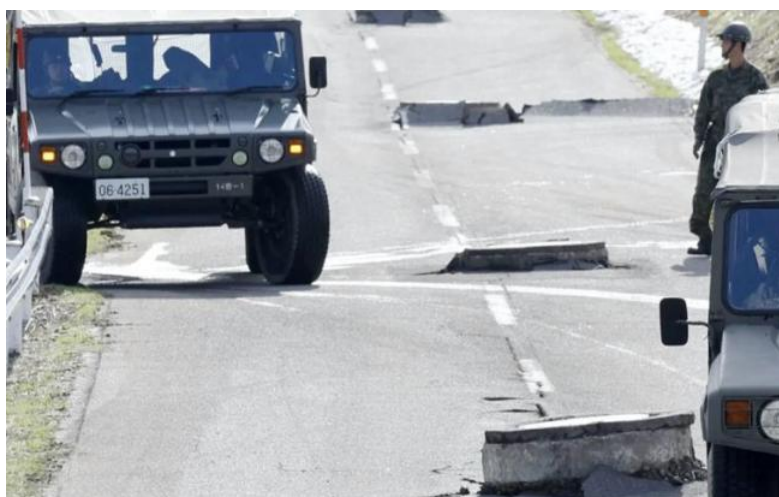
(甲F152・石川県珠洲市・地震によって突き出たマンホール)
