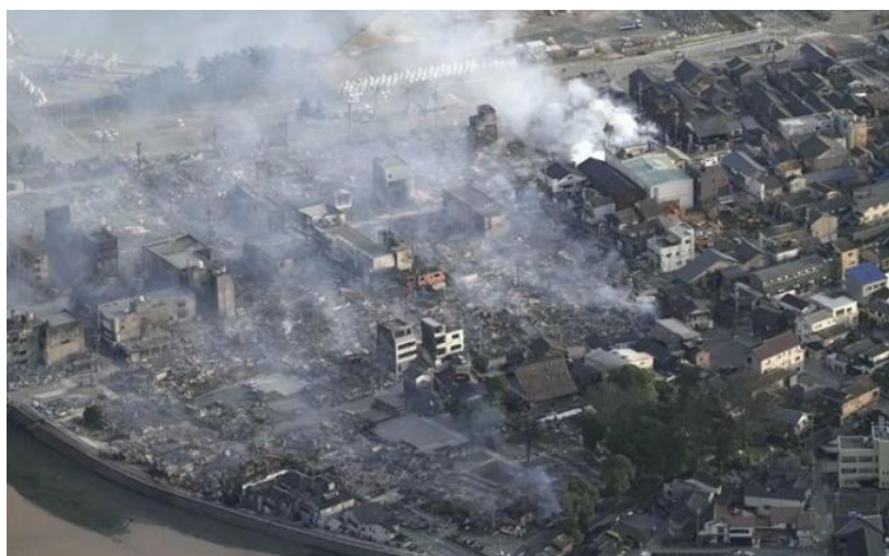
（甲F152・1月2日撮影、輪島市の火災現場）
