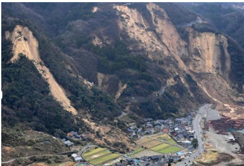
(甲F158・珠洲市、1月3日・国道249号線が寸断)
