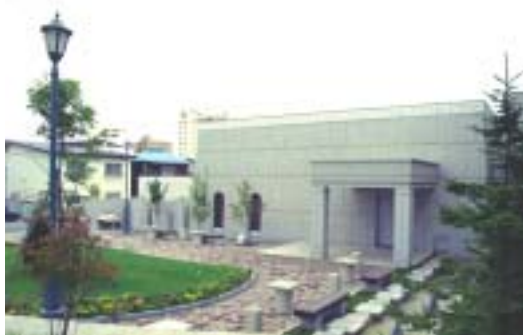
北海道電力(株)末広変電所 敷地内に小公園を設置し, 植栽や人工の小川を設けるなど, 近隣住民に憩いの場を提供しています。また, 歴史的建造物風の雰囲気をかもし出しています。
