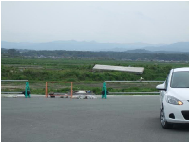
津波で流された橋梁
