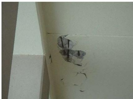
深堀団地(4号棟)：モルタル剥落、鉄筋露出
