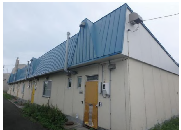
No. 2 新浜町団地
