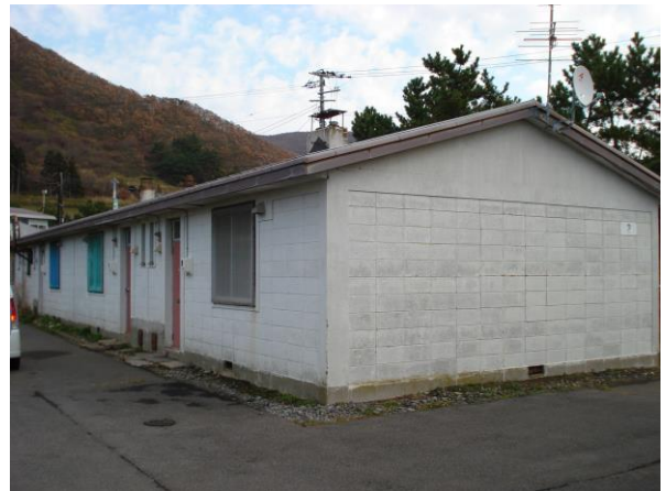
No.2 釜谷町団地
