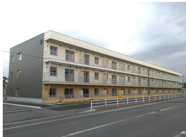
No.6 大川団地
