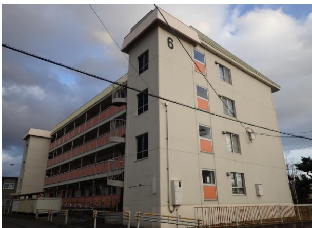
No. 9 深掘団地
