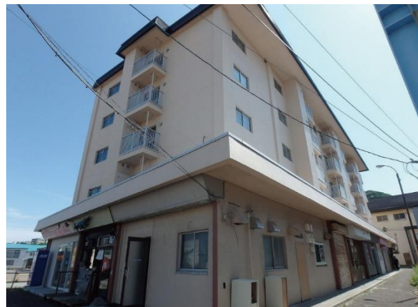
No.2 大町改良団地
