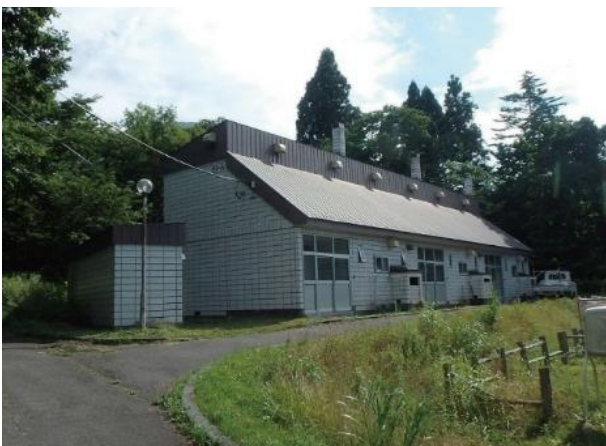
No.1 新八幡町団地
