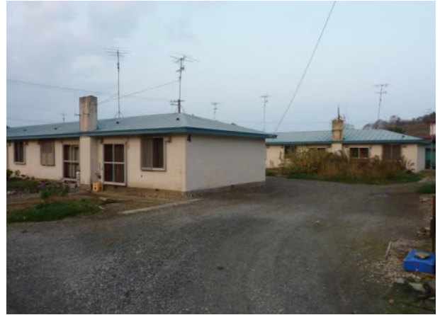
No.1 八木川団地
