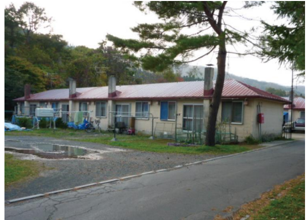
No.9 アスナ口団地
