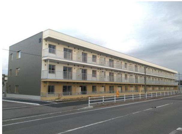
No.6 大川団地
