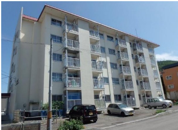
No.1 弁天改良団地
