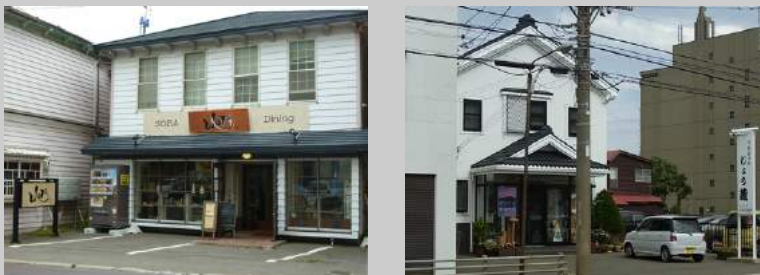
敷地内の建物に調和するデザインとした事例
