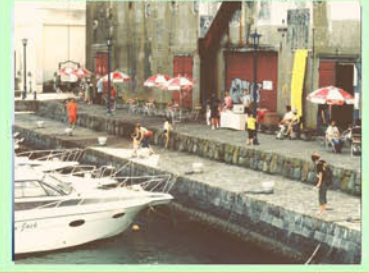
石積を再利用した物揚場
