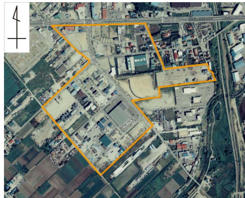
西桔梗地区 ～施行後～ (平成5年撮影)
