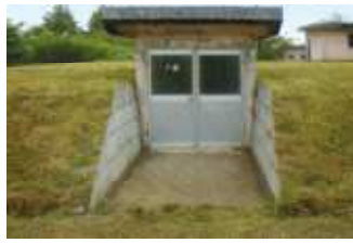
尾札部浄水場
