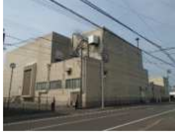
大手ポンプ場 (雨水)
