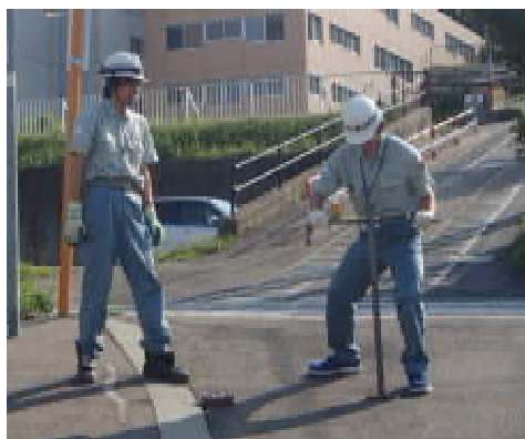
断水作業仕切弁操作訓練
