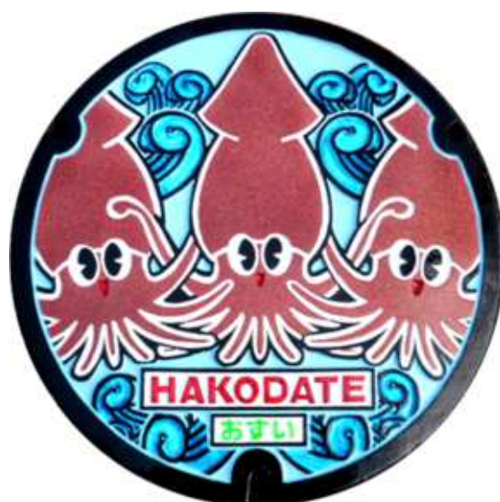
デザインマンホール蓋
