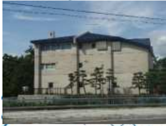
湯川ポンプ場 (汚水)
