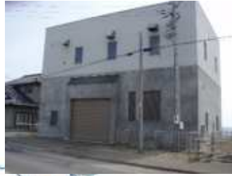
志海苔ポンプ場 (汚水)
