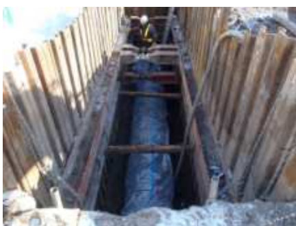
配水管布設工事
