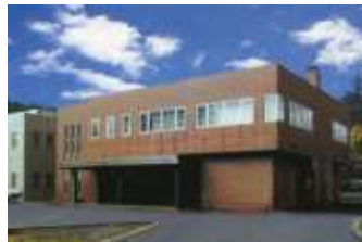
赤川高区浄水場
