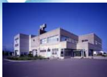
南部下水終末処理場 汚水処理施設管理棟
