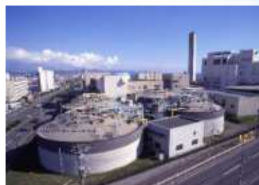
南部下水終末処理場 汚泥処理施設
