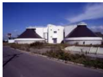
函館湾浄化センター汚泥処理施設
