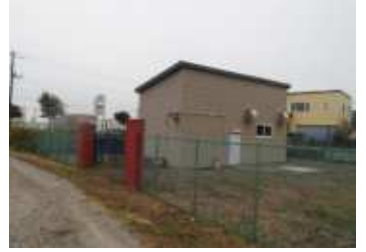
港ポンプ場 (雨水)
