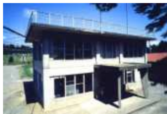
赤川低区浄水場
