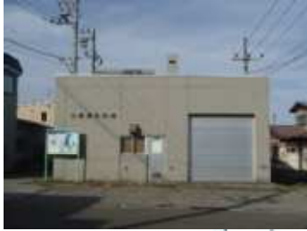
住吉ポンプ場 (汚水・雨水)
