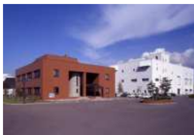
函館湾浄化センター管理棟
