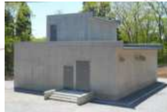
日ノ浜浄水場
