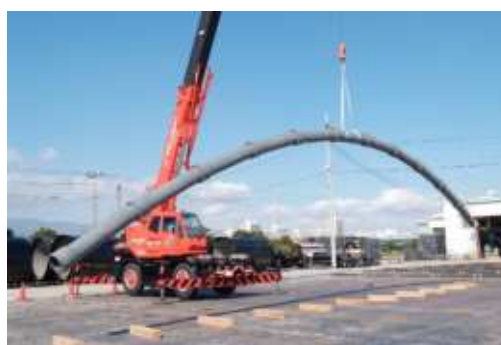
耐震継手の水道管
