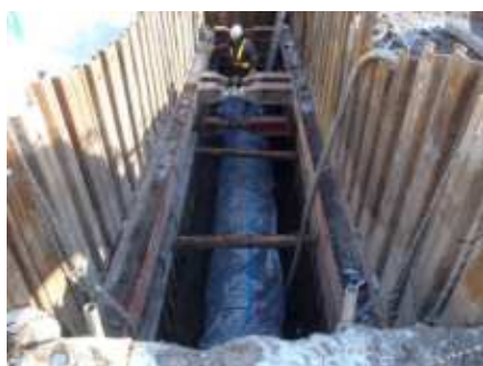
配水管布設工事
