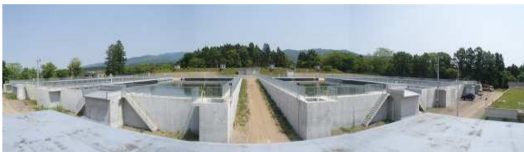
更新後の赤川低区浄水場 2 系緩速ろ過池
