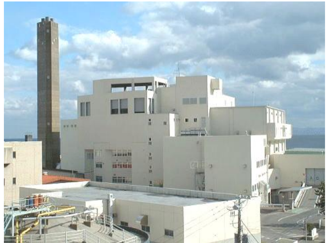
日乃出クリーンセンター (日乃出清掃工場・し尿処理場)
