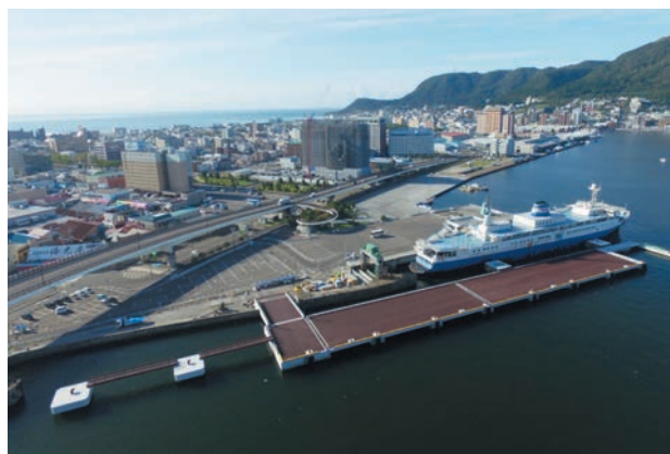
⑩ 11万トン級の大型クルーズ船が接岸できるよう整備を進めている若松ふ頭岸壁の暫定供用が開始(2020年完成予定)。これにより4万トン級までのクルーズ船の接岸が可能に。
