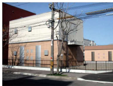
東雲町変電所
